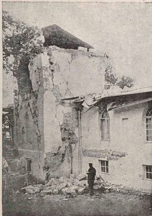
Верхняя Ореанда. Санатория им. Дзержинского, главный корпус. Сброшена и повернута на 40^\circ крыша башни (с 180^\circ 5 на 140^\circ 50 )
