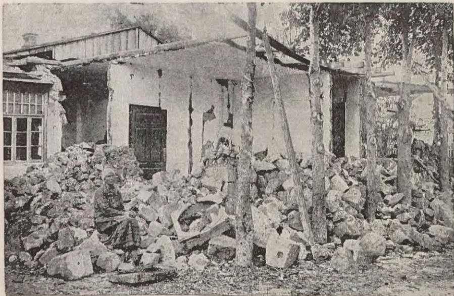
Балаклава, ур. „Левадки“, усадьба Будниковых. Разрушение каменных стен и неповрежденные фаянсовые простенки
