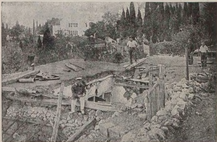
Гурузф. Провал плоской земляной крыши на татарской сакле, в которой погибли двое детей
